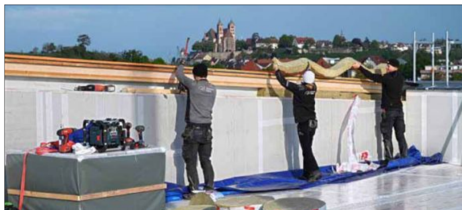
Arbeiten auf dem Dach des neuen Büroanbaus mit 36 Arbeitsplätzen
